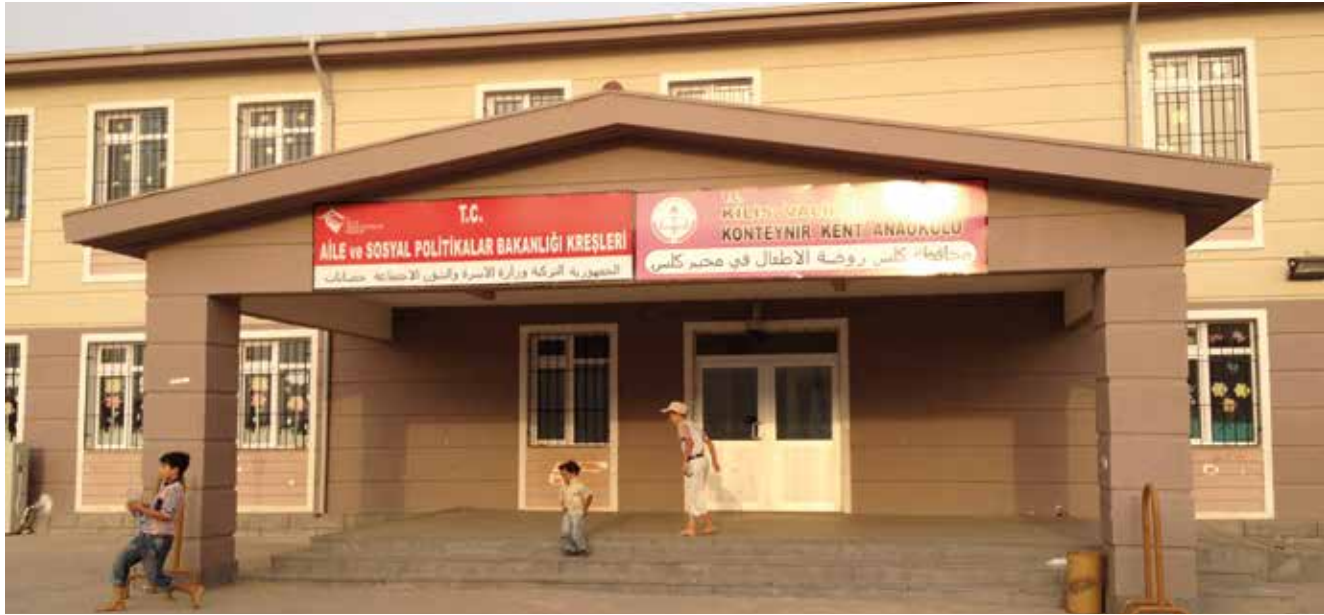
Öncüpınar Container Camp Kindergarten
